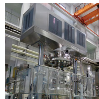
乳化プラント
